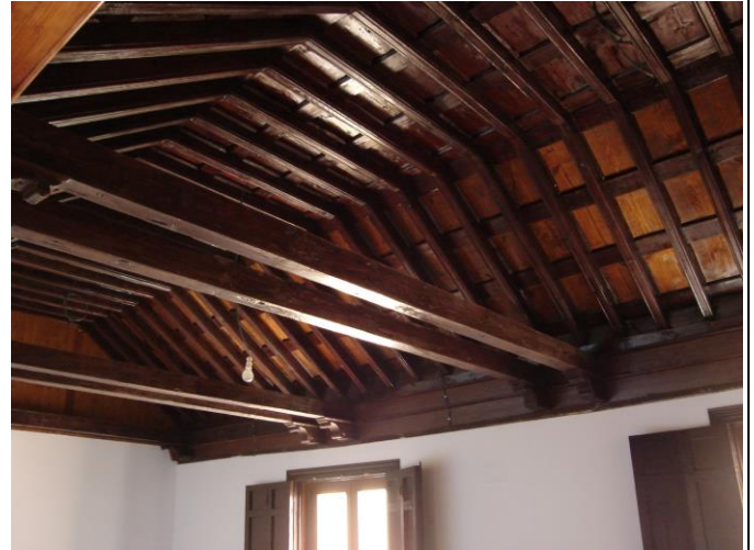
Rehabilitación de casa palacio en Toledo (2006)
